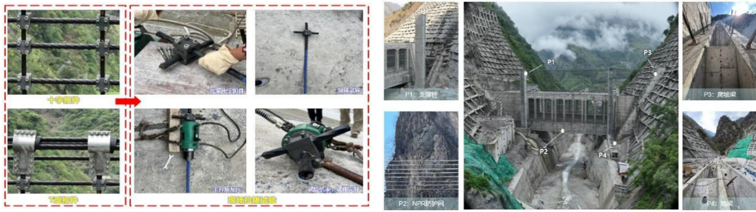
图 8 关键扣件抗滑力试验及高能级柔性防护系统
